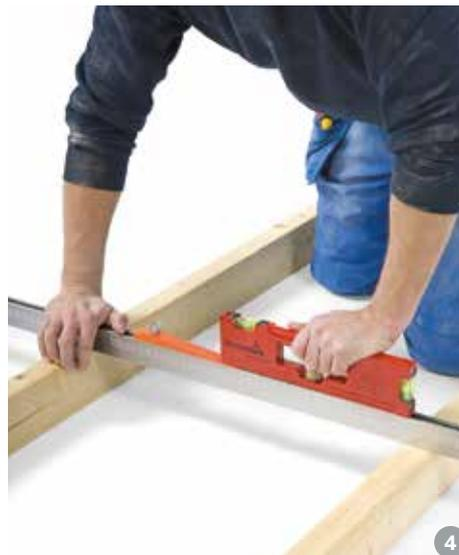
1. Beim Montieren von Rahmen wird die LIBELLA 2000 mit einer Schiene verwendet.
